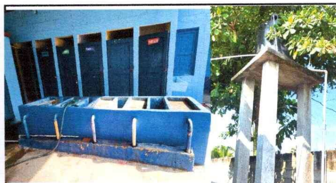
Foto 4: Sustitución de pila para baños y mantenimiento de los baños de cinco lavaderos (cambio de tubería de pvc).
