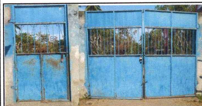
Foto 5: sustitución de 2 portones de ingreso.
