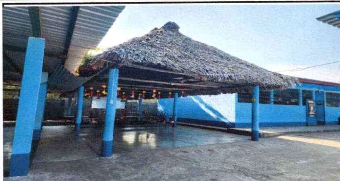
Foto1: Cambio de techo de rancho a enlaminado (lámina troquelada calibre 26 y soporte de metal).
