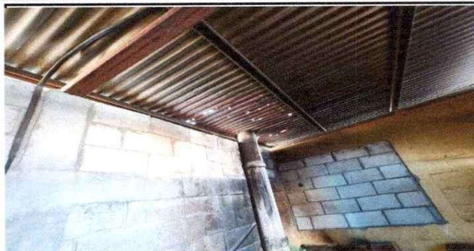
Foto 2: Sustitución de 4 láminas del techo de cocina.
