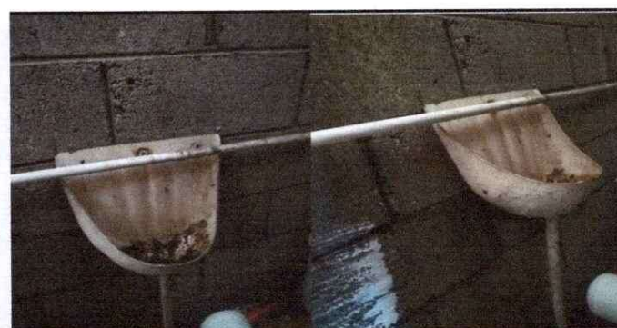
Foto 6: Sustitución de un mingitorio.
